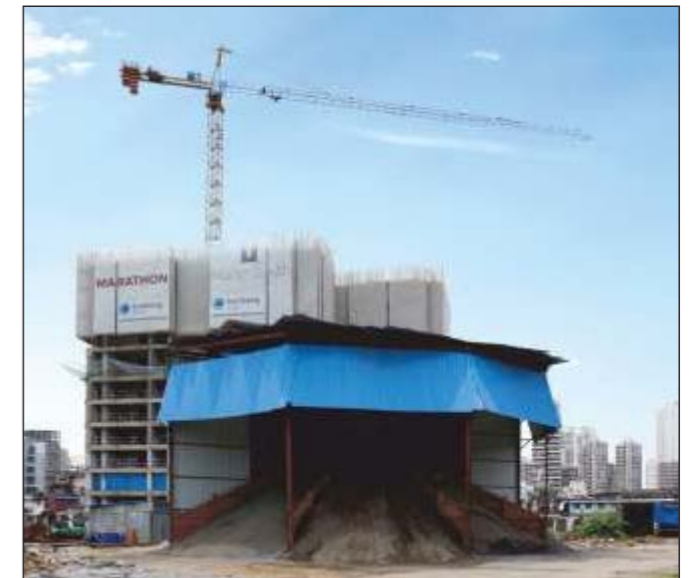
Actual Images - Construction Site
