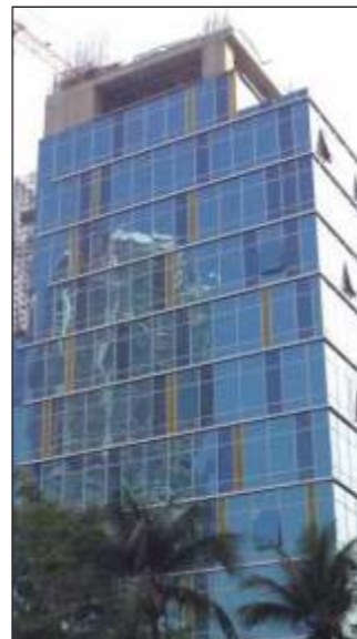
Actual Images - Construction Site
