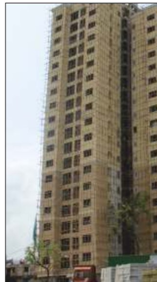
Actual Images - Construction Site
