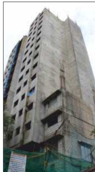
Actual Images - Construction Site
