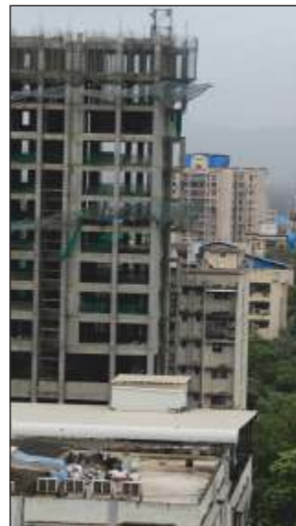
Actual Images - Construction Site
