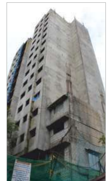
Actual Images - Construction Site
